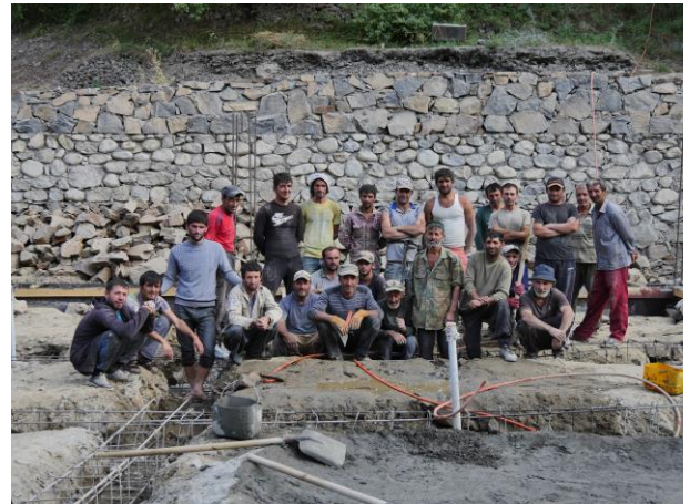
Das Fundament wird betoniert
